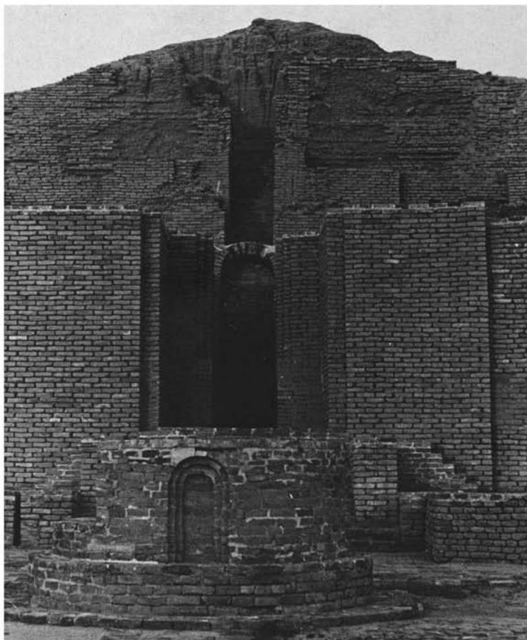
*Fig. 60. La ziqqurat de Tsboga-Zambil, l'ancienne Duruntash, près de Suse, perpétue le type de tour à étages au triple escalier d'accès de la III<sup>e</sup> dynastie d'Ur. Ici se sont conservés des arceaux de briques dont les claveaux ont été moulés en forme. (- XIII<sup>e</sup> siècle.)*
