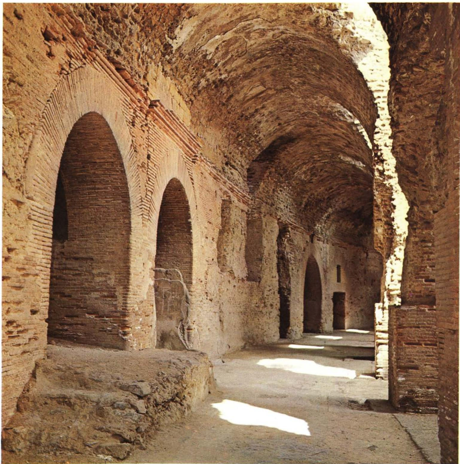
*Fig. 114. La forme même des amphithéâtres attirait l'emploi de l'arceau et de la voûte, déjà employés en Mésopotamie pour des soutènements. Les campagnes en Orient, le trafic de l'Orient vers Pouzsoles, Ostie et Rome, semblent en avoir introduit l'usage, dont témoigne ce grand amphithéâtre de Pouzsoles, construit au Ier siècle et plusieurs fois remanié.*
