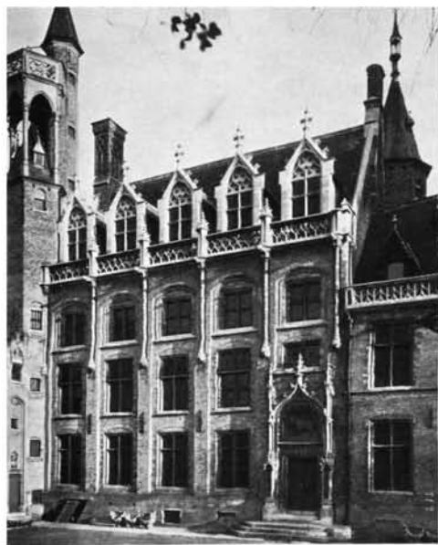
21. GRUUTHUSE MUSEUM, Brugge. Le bâtiment. 21. The building.
