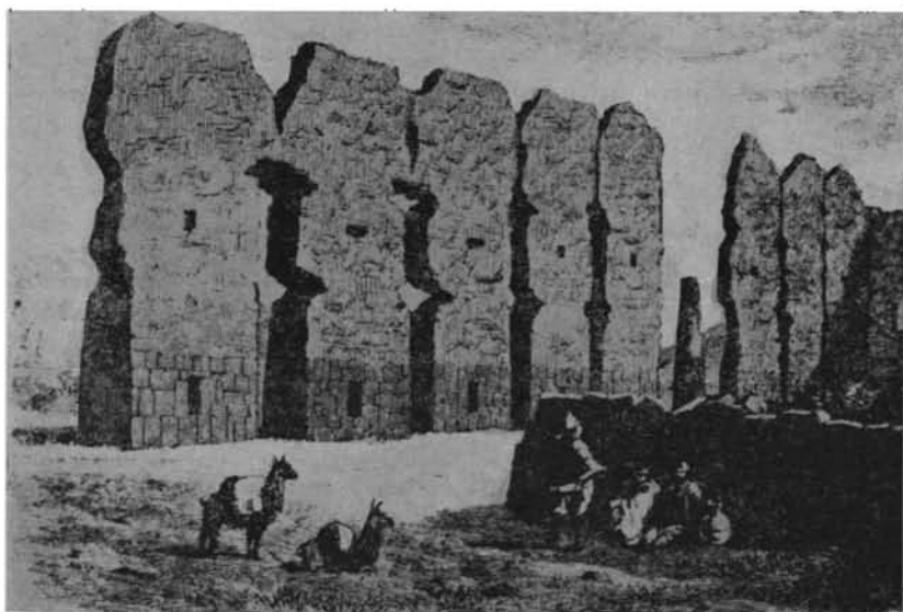
FIG. 3. — Ruines du temple de Huira-Ccocha, à Rajchi.
