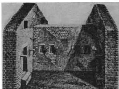
FIG. 5. — Maquette et plan d'une maison à étage, postérieure à la construction du temple de Rajchi. On remarquera le mur médian reliant les pignons gâblés.
