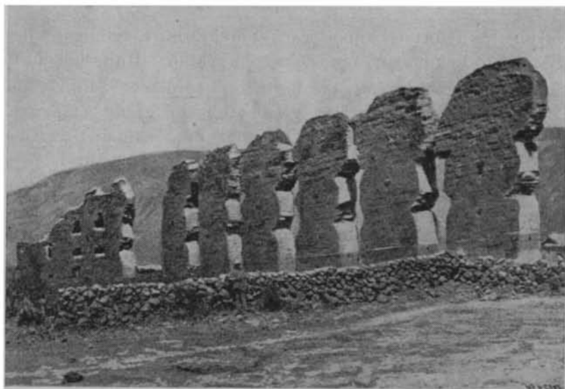
FIG. 2. — Vue du mur médian, en briques sur soubassement de pierres, temple de Huira-Ccocha (Viracocha), à Rajchi.
