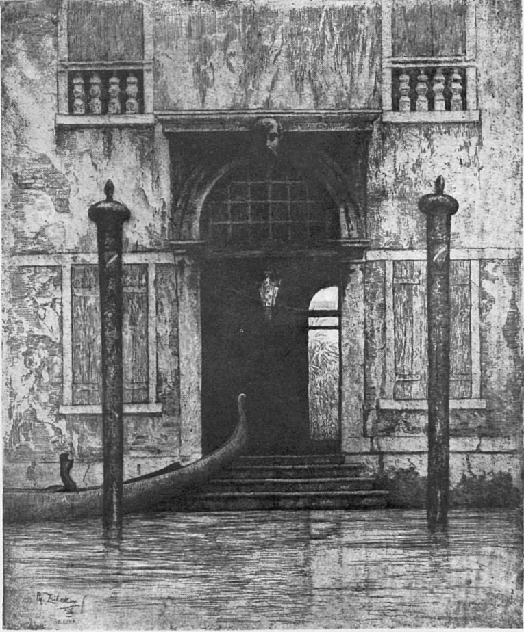
Grandeur déchue. (Venise.) (Eau forte.)
