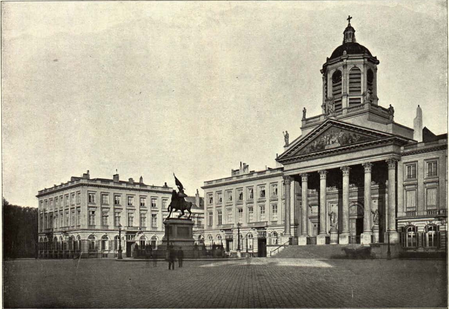
FIG. 15. — Angle nord-est de la place Royale et façade de l'église Saint-Jacques, avec campanile par T.-F. Suys (1849) et fresque, dans le fronton, par J. Portaels (1852). État actuel.
