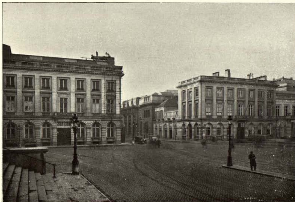
FIG. 23. — Surélévation de la toiture de l'hôtel de Templeuve-Tirimont. Travaux en cours. La claire-voie de la balustrade sera très probablement sacrifiée.
