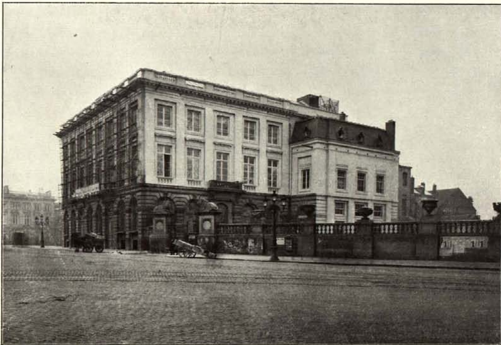
FIG. 25. — Vue du même hôtel après la mutilation, en 1921. Le pavillon n'est plus isolé et la symétrie qu'il présentait avec l'hôtel de Belle-Vue (voir fig. 22) est détruite. Vue vers le Parc.
