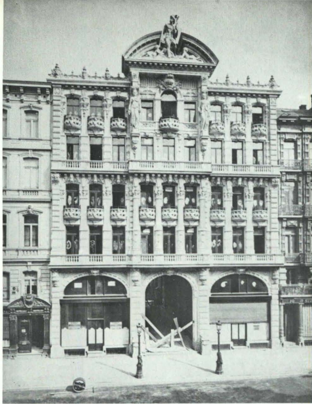
Fig. 6. Passage des Postes. Façade, boulevard Anspach, avant démolition. (Cl. J. d'Osta)
