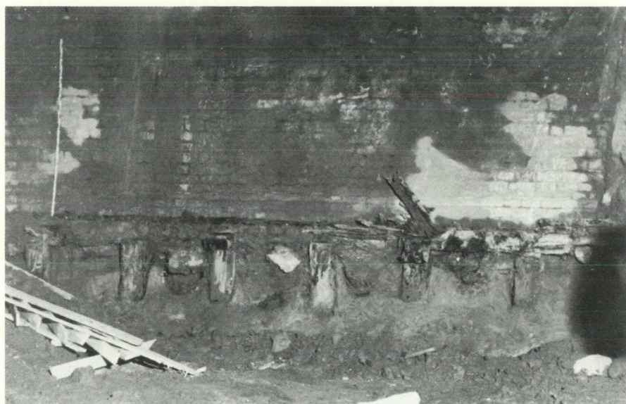
Bruxelles, station Hôtel des Monnaies. Tronçon de mur reposant sur pieux et plancher de bois. Ce fragment est reconstitué dans la station de métro (photo Service des Fouilles).
