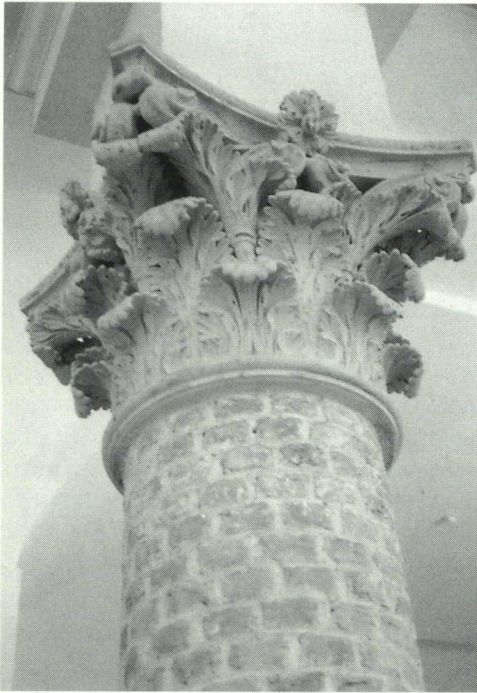
Fig. 3. Centre Culturel de la Communauté française, Le Botanique, Bruxelles, détail des colonnes de la salle des expositions temporaires. (Photo Y. Robert)
