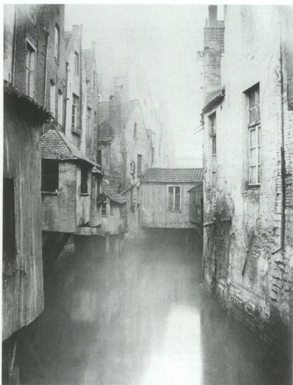
Fig. 4. Louis Ghémar, La vieille Senne photographiée depuis le pont de la Carpe , 1867, tirage sur papier albuminé, Bruxelles, Archives de la Ville de Bruxelles (Jan APERS, Jos VANDENBREEDEN, Linda VAN SANTVOORT, et alii, Pierres et rues. Bruxelles : croissance urbaine 1780-1980 , Bruxelles, Sint-Lukas-archieff/Société Générale de Banque, 1982, p.160.)
